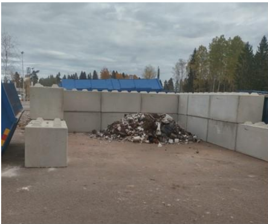
Figur 10. Betongficka på asfalt.
